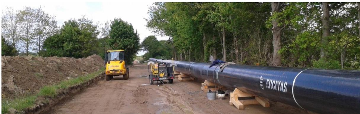
Figure 7 : Exemple de tubes assemblés (source : SETEC hydratec)
