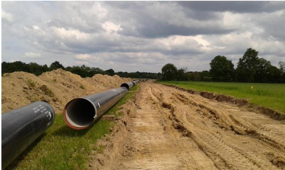
Figure 8 : Zone décapée et dépose des tubes (source : SETEC hydratec)
