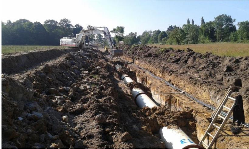
Figure 10 : Exemple de pose d'une conduite (source : SETEC hydratec)
